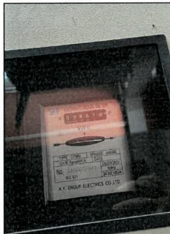
รูปที่ 3-43 มิเตอร์ไฟฟ้าสำหรับระบบบำบัดน้ำเสียโดยเฉพาะแยกจากระบบไฟฟ้าอื่นๆ
